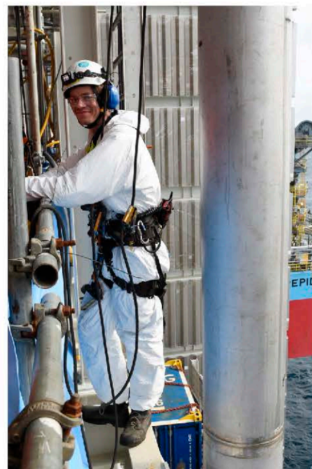
UTEN HØYDESKREKK: Tilkomstteknikker Emil Halvorsen monterer søyler til en vindvegg. Det er litt åpent der han står.
