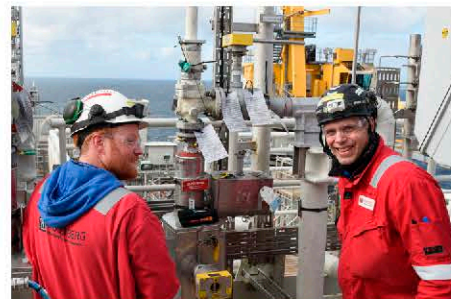
LUFTIG ARBEIDSPASS: Elektrikerne Lars Nielsen og Stian Jespersen trekker varmekabler til rørene, heat trace, og får gått noen høydemeter i dag.
